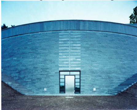
Centre Dürrenmatt in Neuenburg
