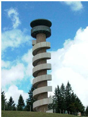
Moron-Turm im Kanton Bern
