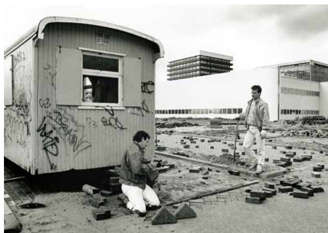
Afb. 1 Uitbreiding van het Academisch Bedrijven Centrum, november 1991. Foto Marc de Haan.
